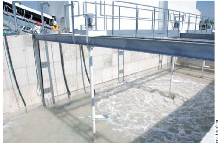
▲ Avec son bassin de récupération et de recyclage des eaux d'une capacité de 580 m<sup>3</sup>, la nouvelle centrale Unibéton valorise le volume dans son process et s'affranchit de tout rejet dans le milieu naturel.
